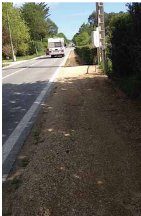
• Travaux de busage Kerzuc/Chat Noir Tranche 2017
